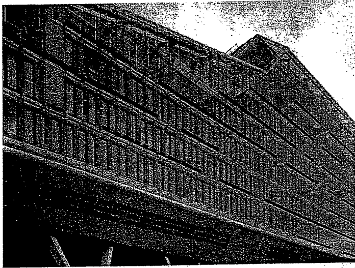
Voorbeeld van een energiezuinig ontwerp, het ING-hoofdkantoor in Amsterdam - Figuur 3.1
